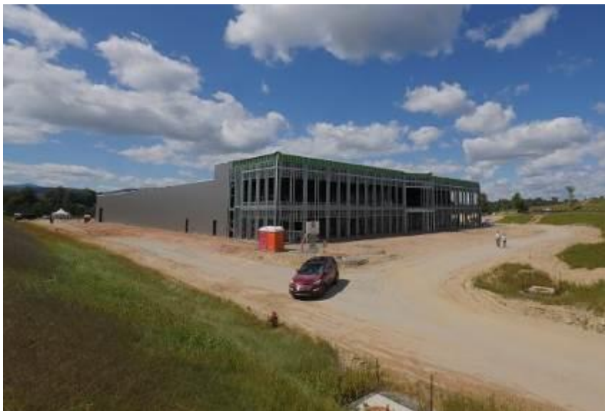
Das neue Werk nimmt Form an
