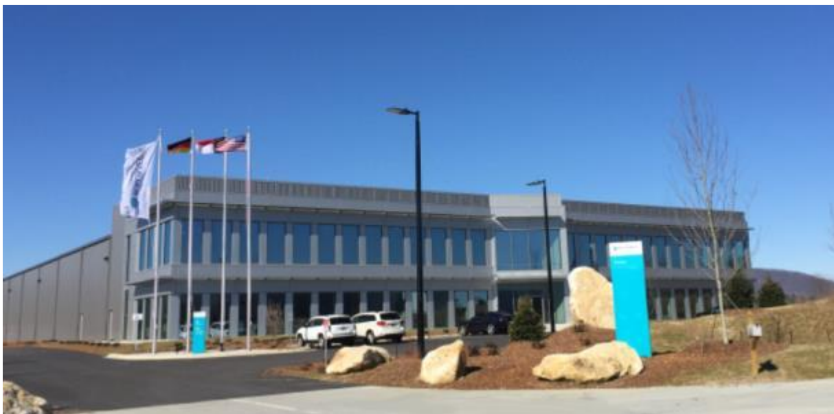
RAUMEDIC Entwicklungszentrum und Produktionswerk in Mills River, NC
